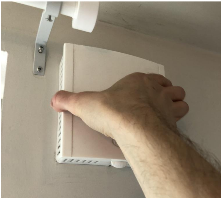
Figur 2: Trekk dekselet ut fra veggen for å komme til filteret
