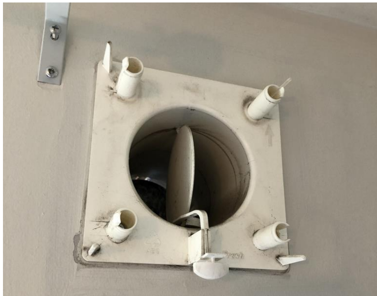
Figur 5: Ventil uten deksel
